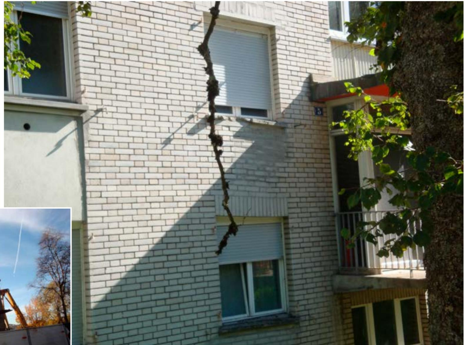
Une partie de la structure reposait sur un terrain instable constitué de matériaux de remblai mal compactés. LDD
